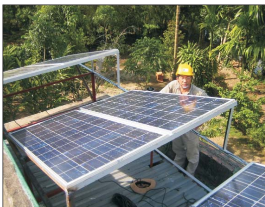
Hình 5.10: Sử dụng các tấm thu năng lượng mặt trời cho trạm cấp nước
